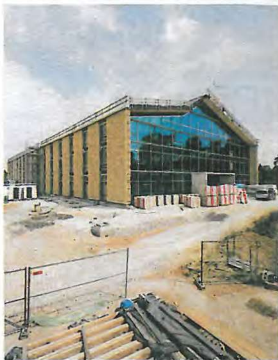
Die riesigen braunen Mauern des Neubaus bestehen aus Lehm, Schotter, Erde und Steinen
