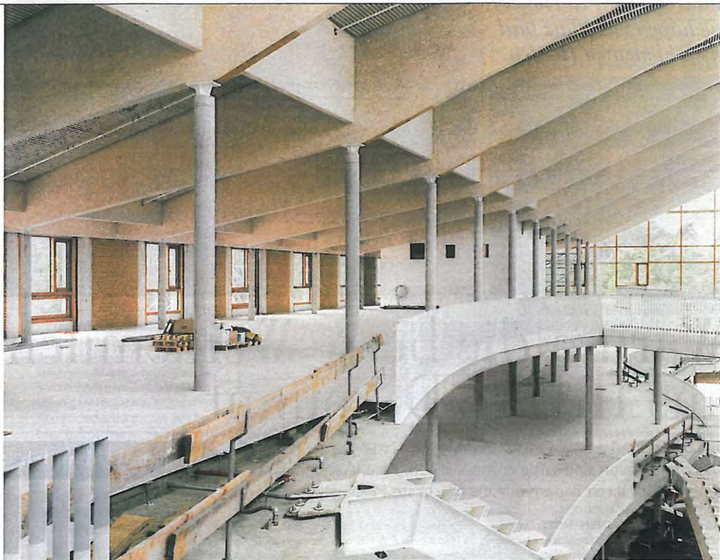
In Darmstadt entsteht das Verwaltungsgebäude der Bio-Supermarktkette Alnatura. 500 Beschäftigte sollen hier arbeiten
